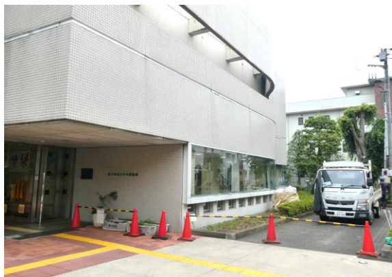
中央図書館 正面玄関側
